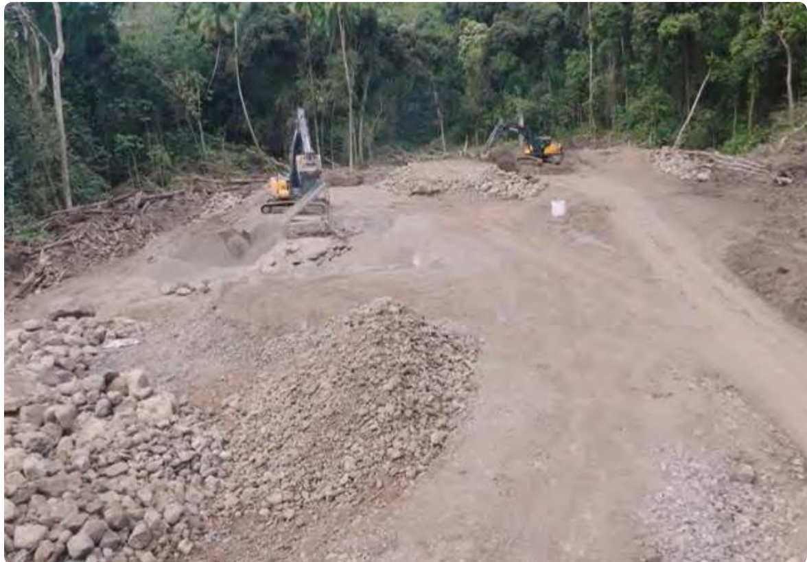
A3407 (41ha 35a 75ca): Autorisation d'extraction de 8600 m3 - avril 2025
